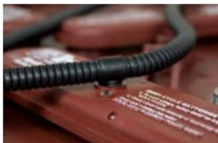
Tubería sin abrazaderas
